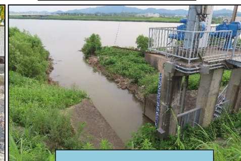
遠賀川取水口
